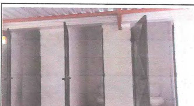
Foto 4: REMOZAMIENTO DE LOS BAÑOS
