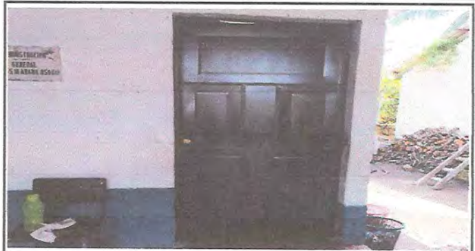
Foto 2: REMOZAMIENTO DE PUERTA
