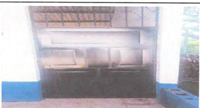
Foto 5: REMOZAMIENTO DE PUERTA
