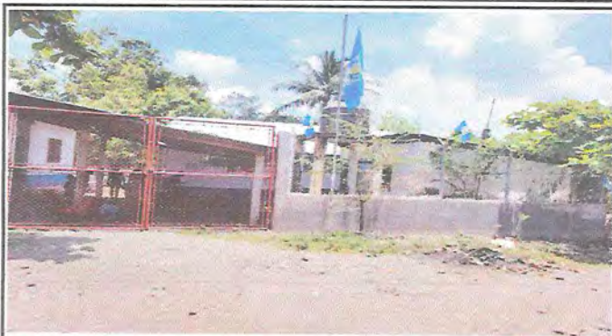
Foto 1: REMOZAMIENTO DE PINTURA DE PORTON
