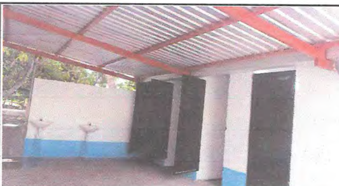
Foto 3: REMOZAMIENTO DE LOS BAÑOS
