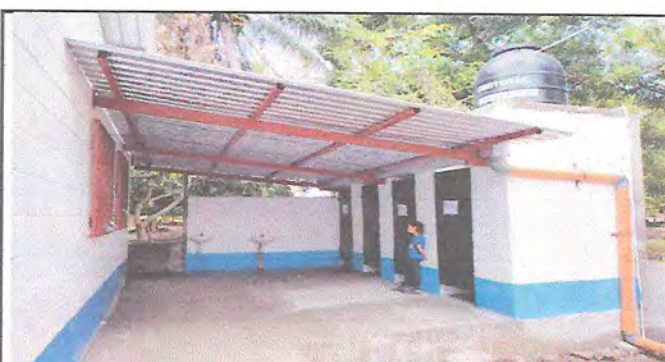
Foto 6: REMOZAMIENTO DE LOS BAÑOS
