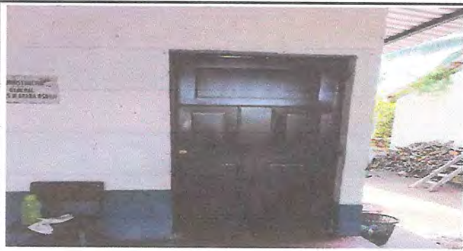
Foto 3: REMOZAMIENTO DE PUERTA
