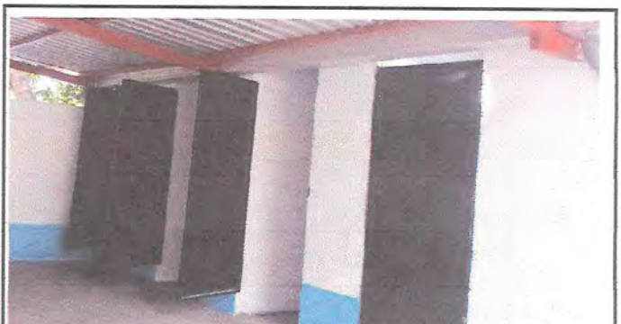
Foto 4: REMOZAMIENTO DE PUERTA
