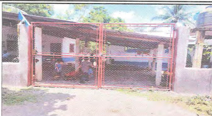
Foto 2: REMOZAMIENTO DE PINTURA DE PORTON
