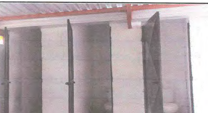
Foto 5: REMOZAMIENTO DE LOS BAÑOS
