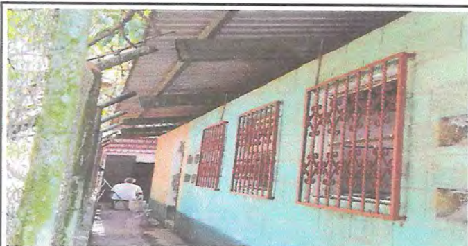
Foto 3: REMOZAMIENTO DE PINTURA DE BALCONES
