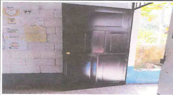
Foto 1: REMOZAMIENTO DE PUERTA
