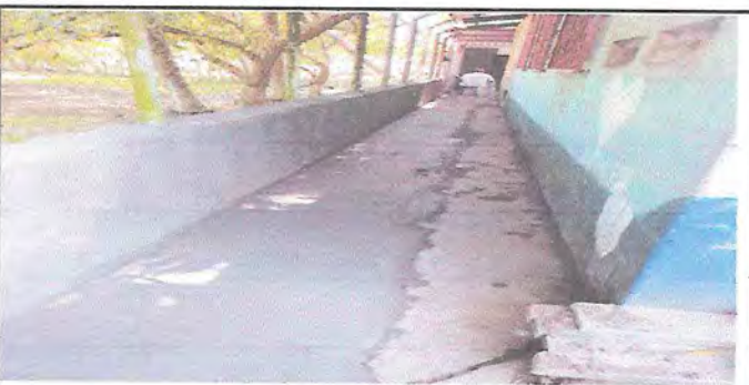
Foto 5: REMOZAMIENTO DE MURO PERIMETRAL
