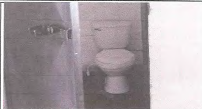
Foto1: REMOZAMIENTO DE LOS BAÑOS
