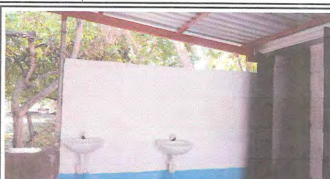
Foto 2: REMOZAMIENTO DE LOS BAÑOS
